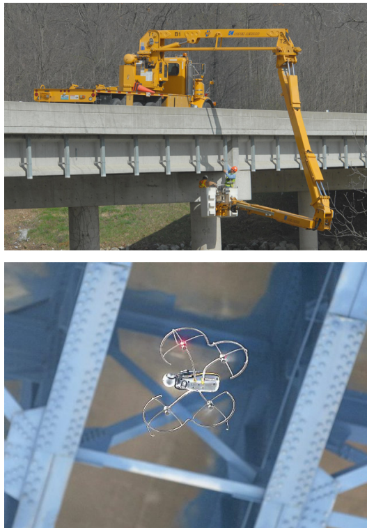
[그림 1] (위) 대형 트럭 스누퍼를 이용한 교량 점검 모습
